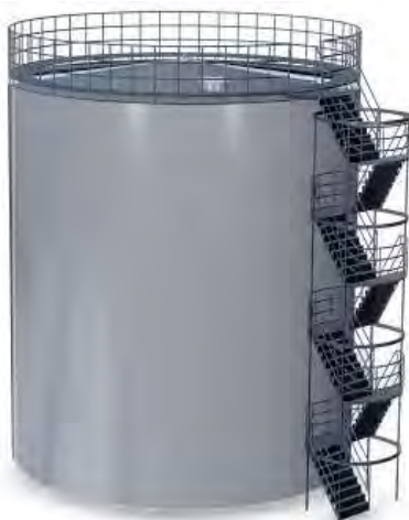
Рис. 1. Пожарный резервуар объемом 600 \text{ м}^3
